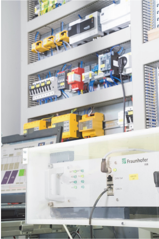
Gleichspannungsmodul des modular aufgebauten intelligenten Energieknotens mit Netzregel­einrichtung (DC-Gridmanager des IISB im Bildvordergrund) und Wechselrichtern. Bild: Anja Grabinger / Fraunhofer IISB
